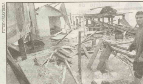
Em SV, três barracos caíram na água no núcleo México 70
